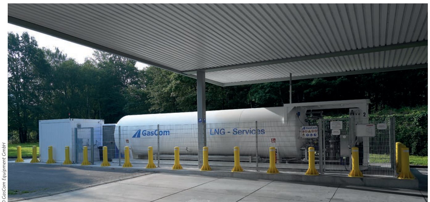
LNG-Füllanlage mit Anfahrerschutz
